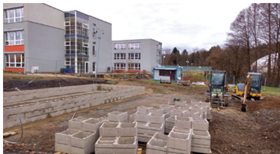
Stavba venkovní učebny již byla zahájena
