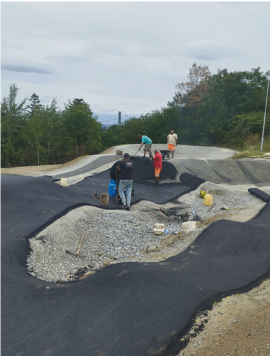
Asfalt na pumptrack nanášeli pracovníci firmy ručně a postupně po jednotlivých úsecích.
