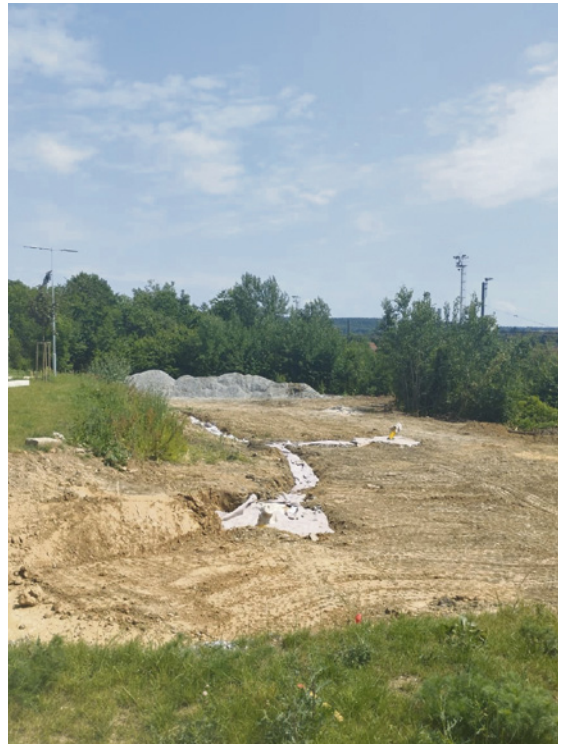
Na začátku stavby musel být celý pozemek odvodněn.
