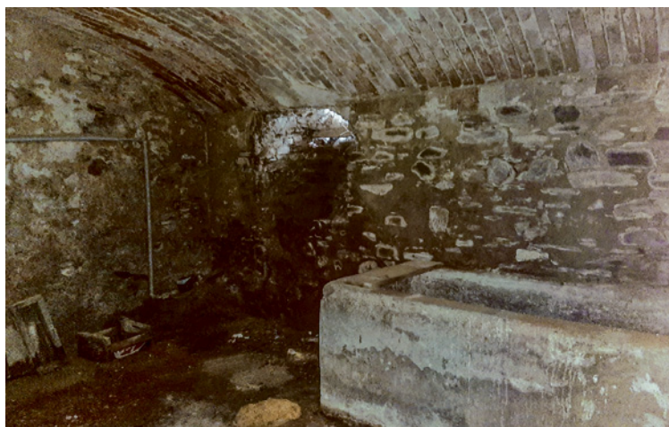
Cihlou zaklenutý sklep s vanou v rohu
