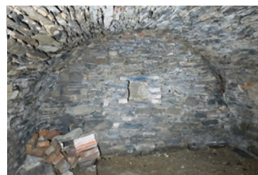
Precizně provedená klenba a stěny včetně niky
