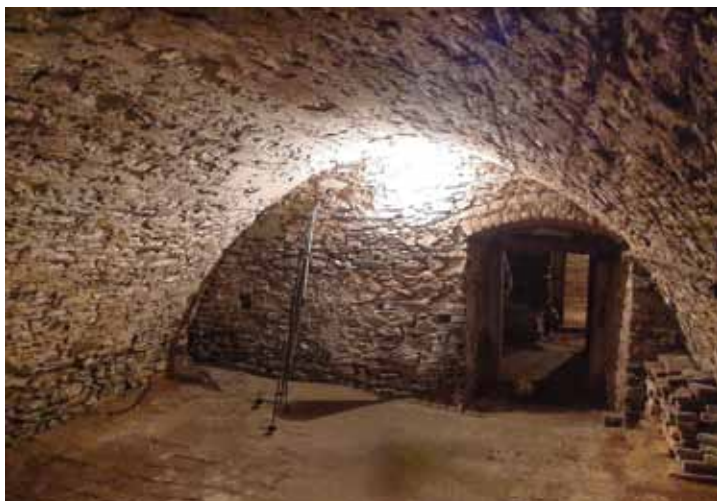
Kamenná klenba sklepa pamatuje jistě 18. století.
