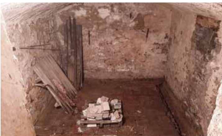
Do zachovalého sklepa s klenutým stropem se schází přes poklop
