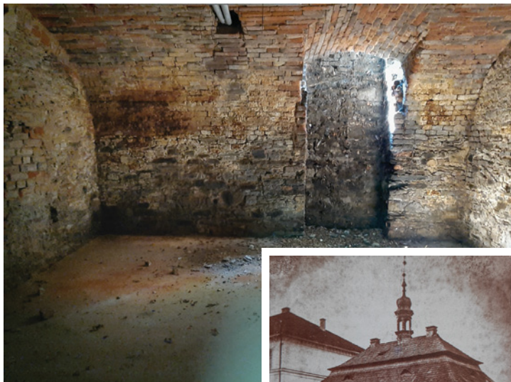
Dolní části obvodových zdí radničního sklepa pocházejí patrně ze 17. století
