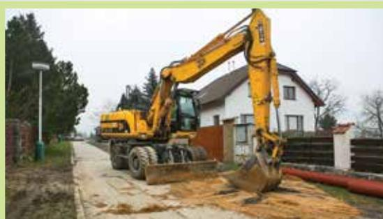
Od března roku 2012 probíhá dostavba kanalizační sítě a kanalizačních přípojek v Říčanech. Projekt se týká deseti lokalit a zahrnuje pasportizaci stávajícího stavu, realizaci kanalizačního řadu a domovních přípojek a finální opravy povrchu dotčených komunikací. Projekt dostavby kanalizace patří mezi největší investiční akce města v tomto období. Dokončení projektu je naplánováno letos na jaře.
