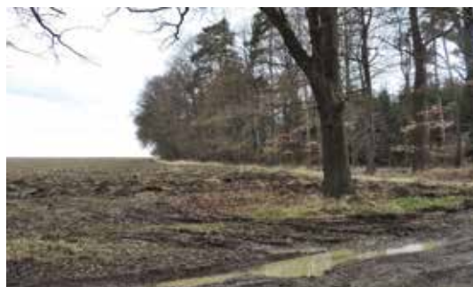
Z tohoto místa u Tehovských polí pramení potůček, který zničil během červnových povodní jednu z hlavních lesních cest. Právě tady vznikne malá lesní nádrž.
