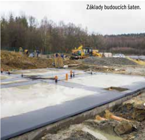
Kotvení nafukovací haly.
