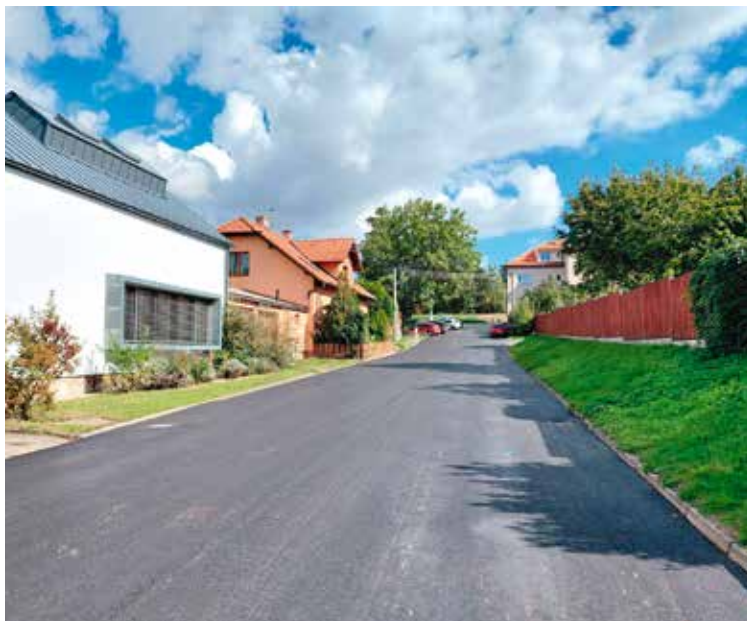
| ↑ | ULICE K PODJEZDU
