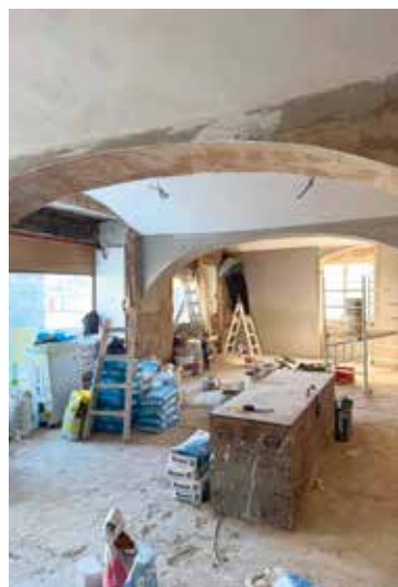
↑ | REKONSTRUKCE DOMU LÁZEŇSKÁ ULICE
