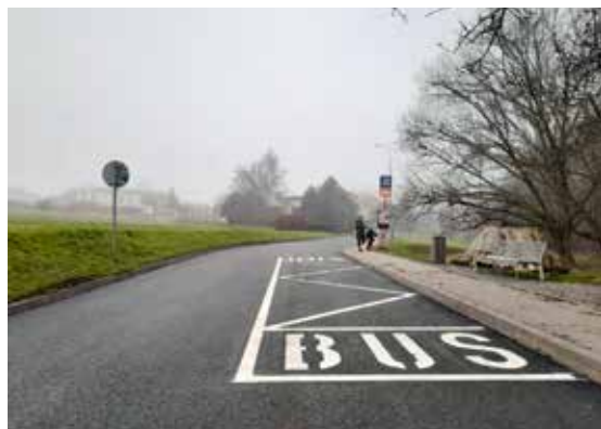
| ↑ | OPRAVENÝ ÚSEK ULICE 5. KVĚTNA
