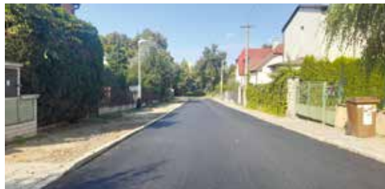
↑ | ULICE OTAVSKÁ DOSTALA PO OPRAVĚ VODOVODU A KANALIZACE NOVÝ ASFALTOVÝ POVRCH
