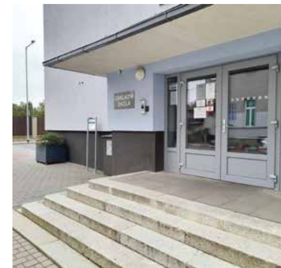
↑ | BUDOVA 2. ZŠ V SOKOLSKÉ ULICI
