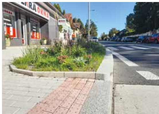
↑ | ŘEŠÍME KAŽDÝ DETAIL, NAPŘÍKLAD NAPOJENÍ OBRUB, NÁJEZDŮ NEBO SEŠÍKMNÉ HRANY KVŮLI BEZPEČNOSTI
