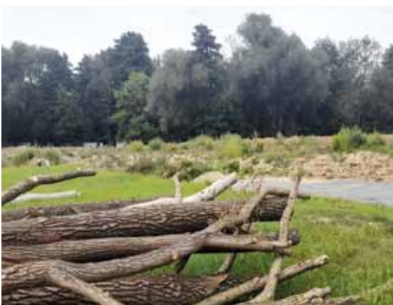
Areál je po náročných demolcích hal připraven pro další úpravy.
