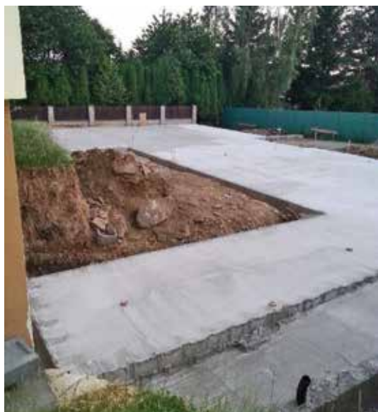
Stavba stacionáře je v plném proudu, v polovině června je hotová základová deska.
