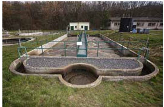
Nedostatečná kapacita čistírny odpadních vod
